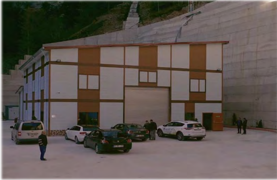
Fotoğraf 12: Santral binası
