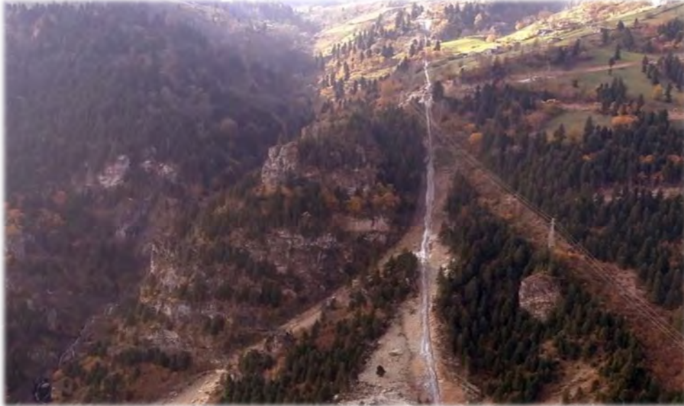
Fotoğraf 18: Cebri boru hattı - Nebati toprak da kullanılarak kanal kapatılmış ve doğal yapıya uygun hale getirilmiştir.
