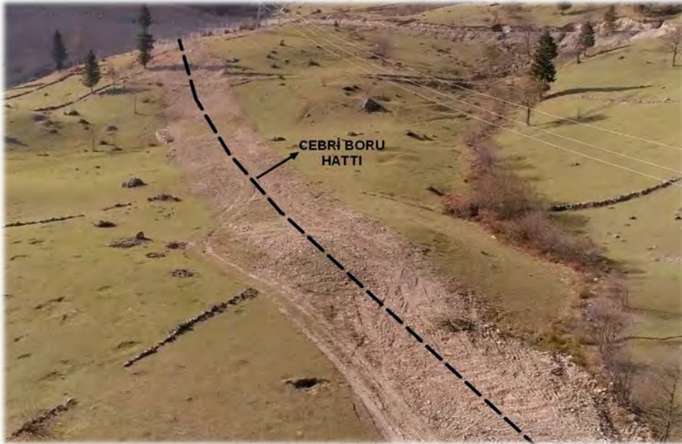
Fotoğraf 10: Cebri boru kanal tesisi sonrası
