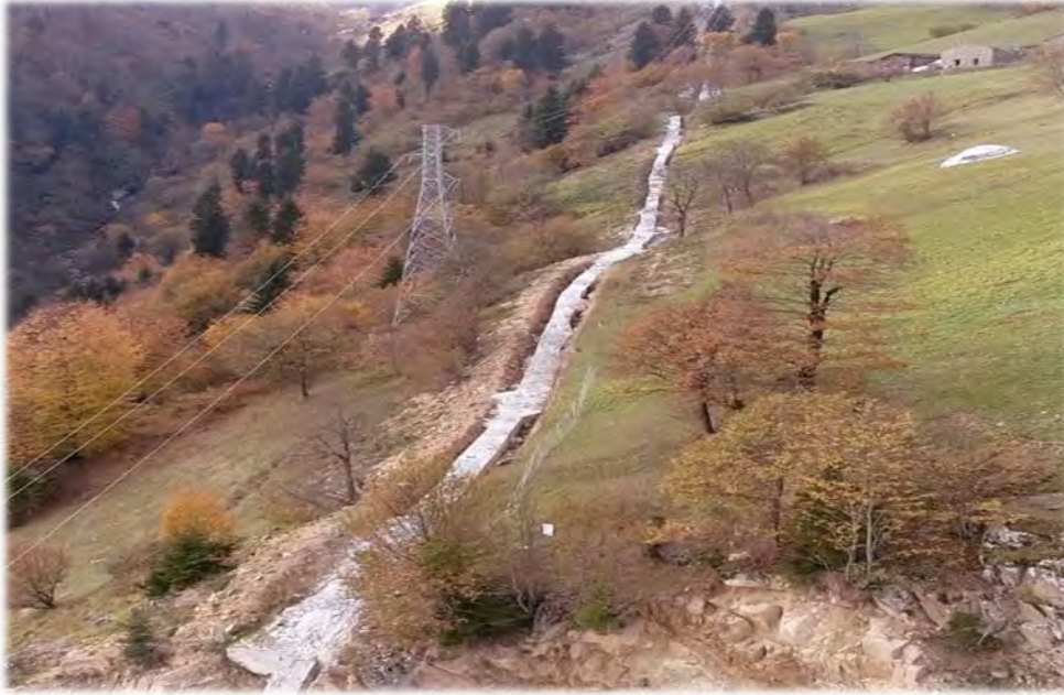
Fotoğraf 9: Cebri boru beton zarfı - Nebati toprak da kullanılarak kanal kapatılmış ve doğal yapıya uygun hale getirilmiştir.
