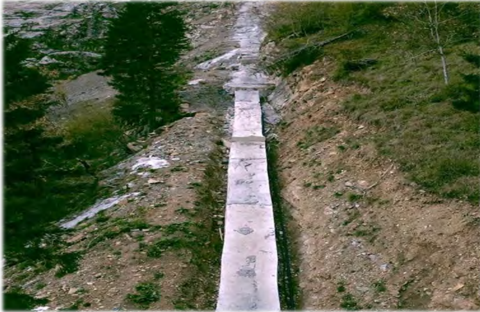
Fotoğraf 8: Cebri boru beton kaplama - Nebati toprak da kullanılarak kanal kapatılmış ve doğal yapıya uygun hale getirilmiştir.
